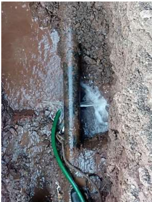
Prasklý vodovod v Drválovicích
