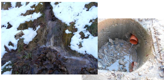
Voda vytékající z odvodnění fotbalového hřiště
